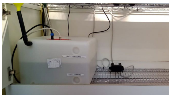
Serbatoio acqua e soluzioni nutritive
